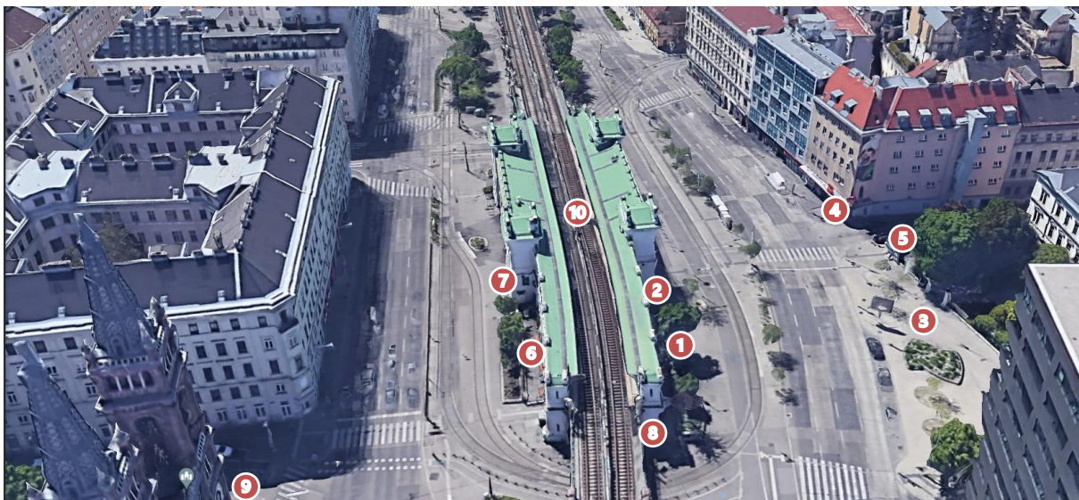
Abbildung 1: Station Josefstädter Straße 5
