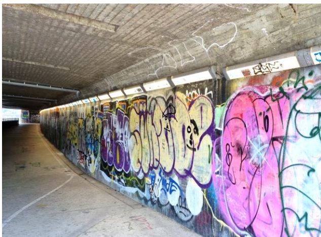
Abbildung 34: Wienfluss, Unterführung Kennedybrücke © Team Focus
